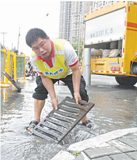
秀峰路磐石路口,小李正在排水
