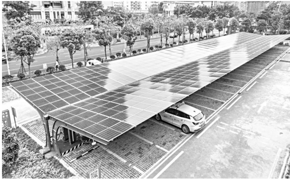
充电站顶棚铺满太阳能板
