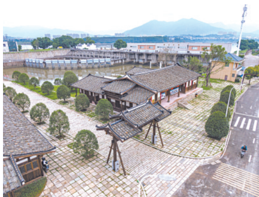
五水公园内的历史建筑已修缮完毕
