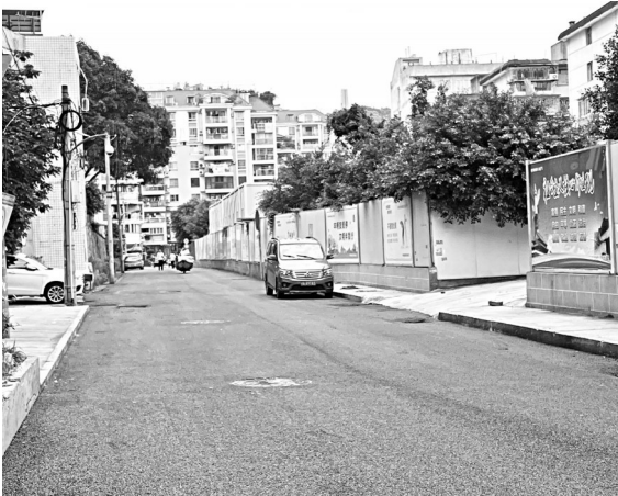
榕信三区前的马路已铺沥青
