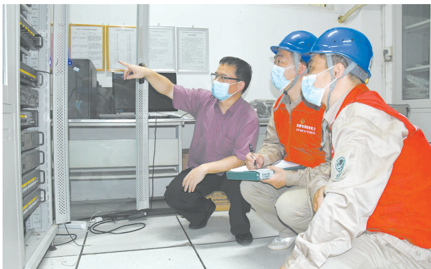
对考点展开保供电特巡 国网福州供电公司保电人员
