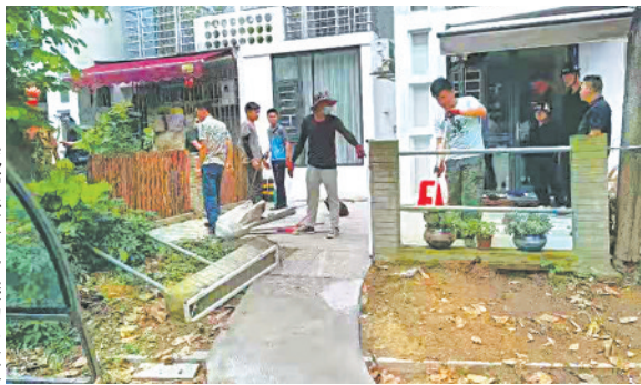
城管拆除一楼的违建
