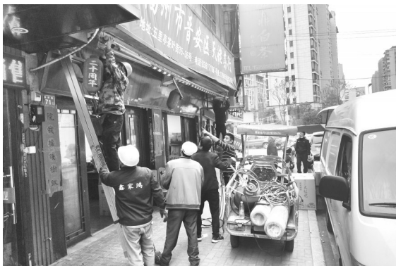
晋安区沿街店铺违建将全部拆除
