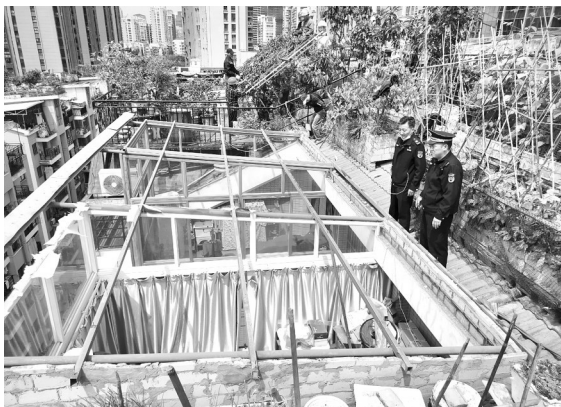
晋安区部分小区顶层违建情况较多,执法人员逐一上门摸底
