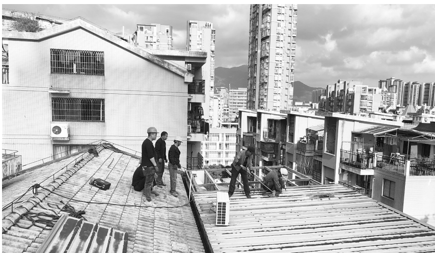
晋安城管组织人员拆除小区顶层违建
