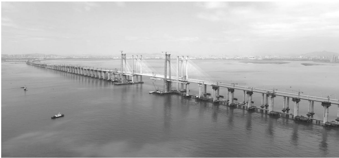
泉州湾跨海大桥
