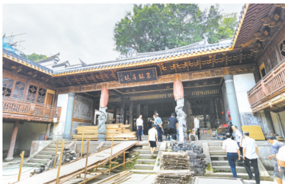
安澜会馆正在加紧修复,国庆将全面开放
