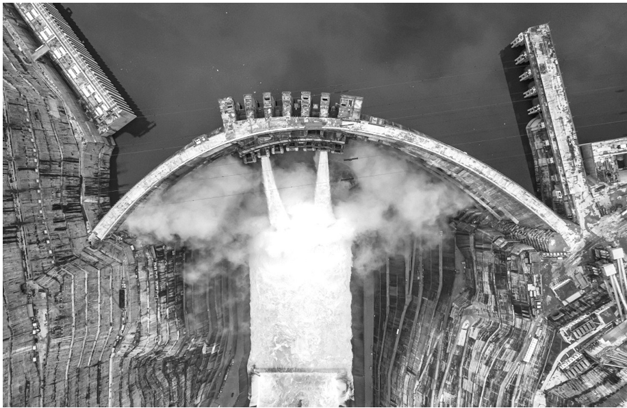
水电站大坝为300米级特高混凝土双曲拱坝
