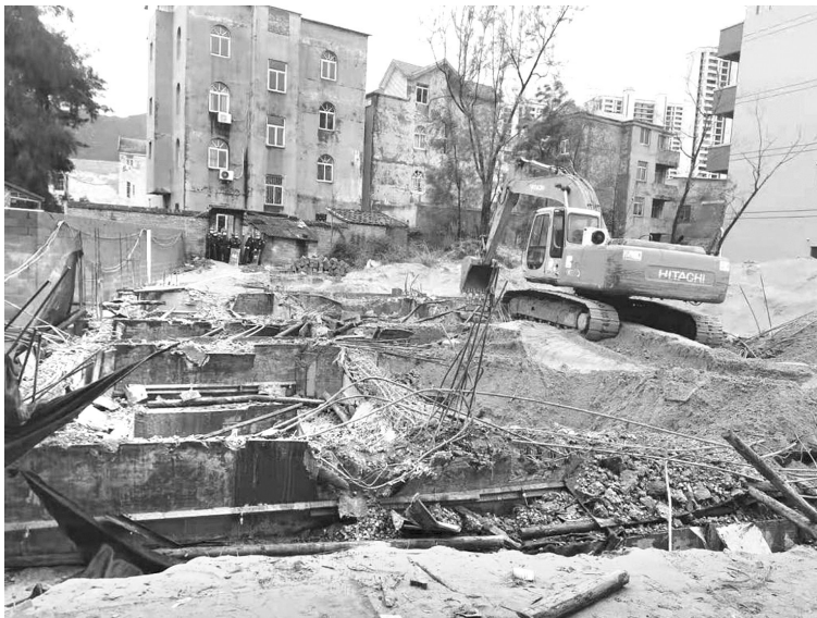
江田镇一新建地基被挖
