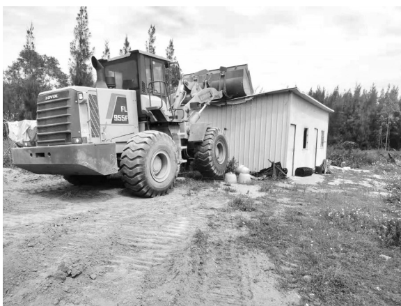
违建活动房被拆除
