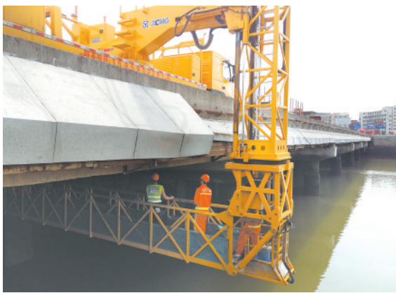
工程人员利用大型桥梁检测车对专养公路桥梁进行“体检”
