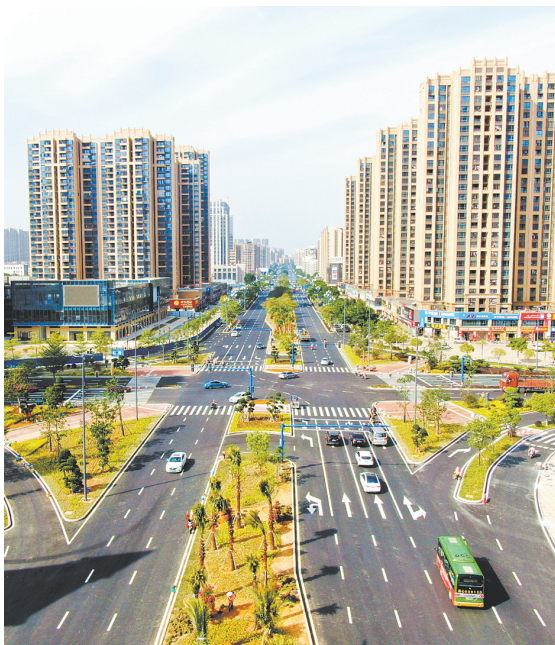
城南新区世纪大道沥青化改造完成，方便群众出行（许晓川/摄）
