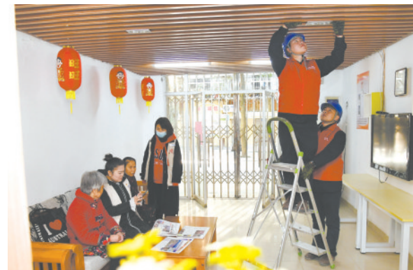
国网福州供电公司共产党员服务队队员在河南社区养老中心义务维修照明线路
