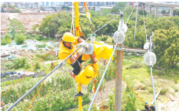
国网福州供电公司员工开展直线杆改耐张杆作业
