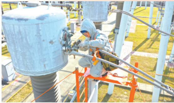
国网福州供电公司检修人员对发热隐患进行带电消缺
