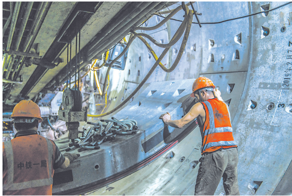
工人正在拼装盾构管片
