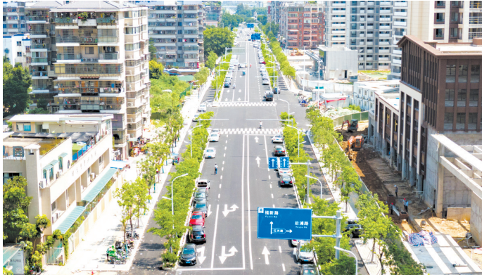
连潘路双向四车道,两侧留有非机动车道和人行道
