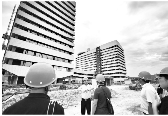
上海大学附属南安医院一期即将竣工验收
