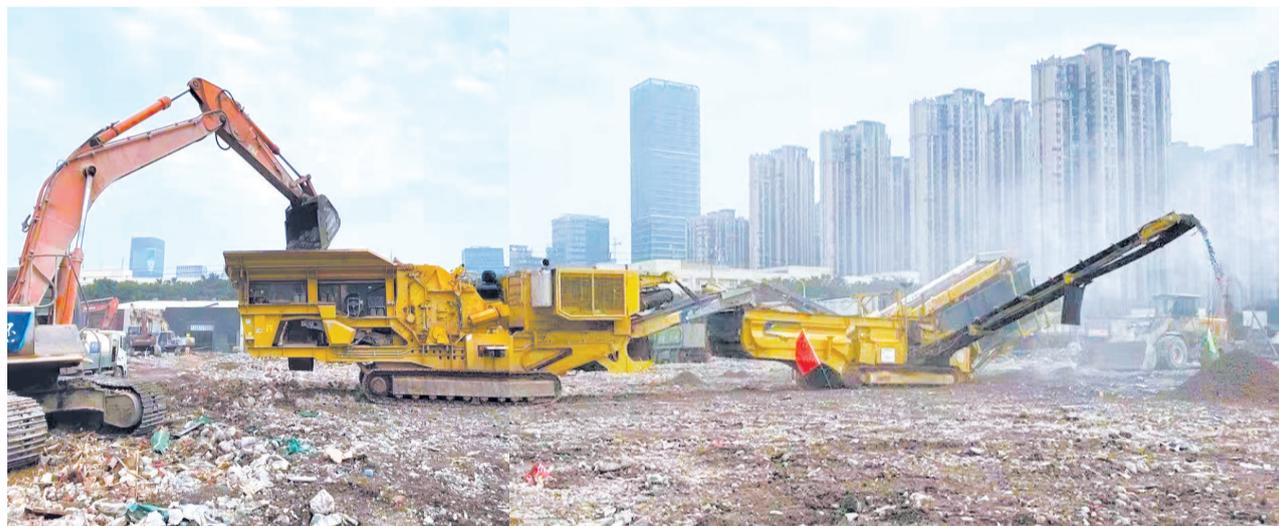
移动破碎设备将砖块混凝土破碎、筛选后，自动分成5类骨料，骨料可实现再利用(拼接图)
