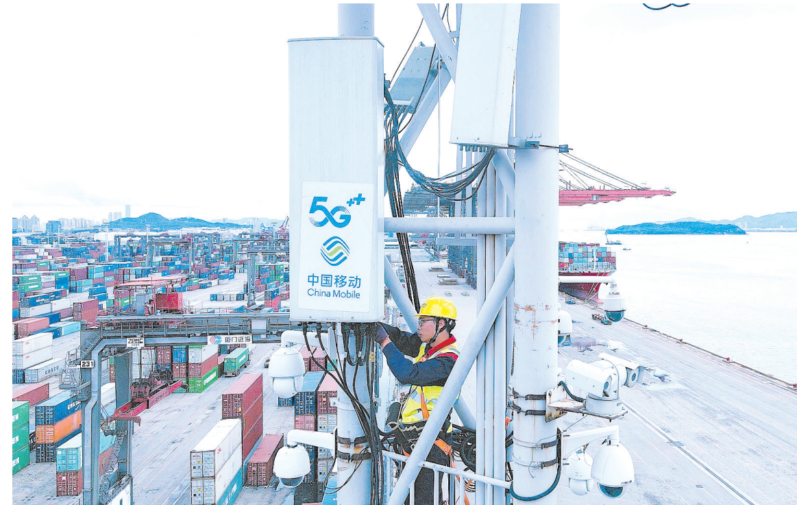
福建移动厦门分公司工程师在厦门远海码头建设5G基站
