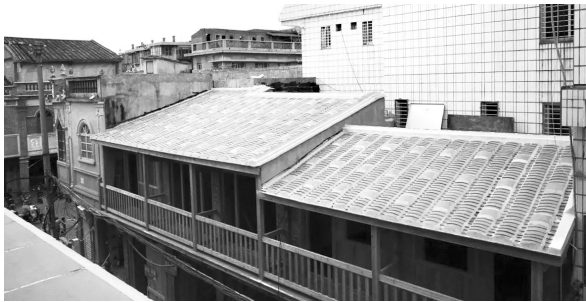
施工方用传统瓦片代替瓷砖进行修缮
