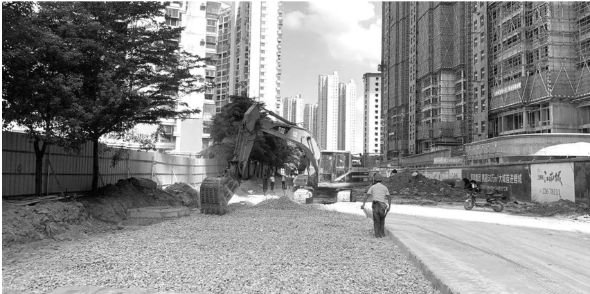
荔春路已进入路面基层施工阶段
