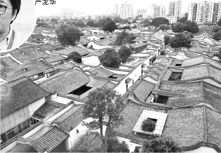
俯瞰三坊七巷,屋顶就像万顷波浪般延伸铺展开来,画面甚是壮观
