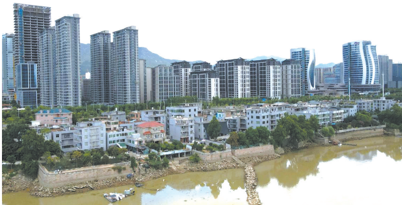
沿江民房根据后面高楼群的设计,做到颜色统一
