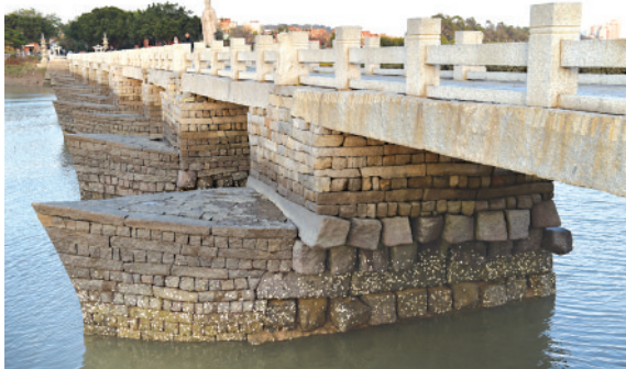
洛阳桥的桥基(田米/图)
