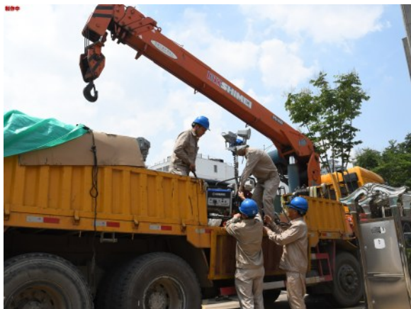
国网福州供电公司抢修人员在逸泉酒店附近进行抢修物资调配,确保抢修进度
