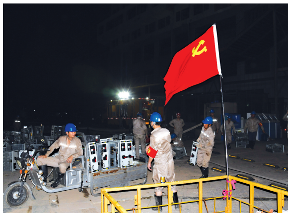
国网福州供电公司抢修人员在财富天阶小区开展电力抢修
