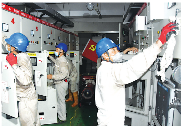
国网福州供电公司抢修人员在郑州经开区橡树玫瑰城小区开展电力抢修
