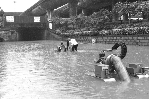
昨日,三环辅道魁浦大桥下,龙吸水在排水
