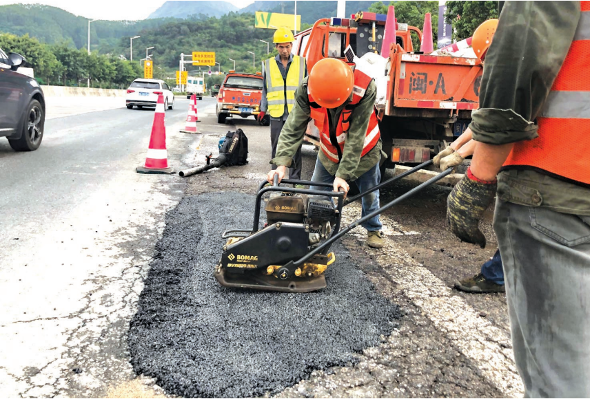
施工人员正在现场修复坑洞
