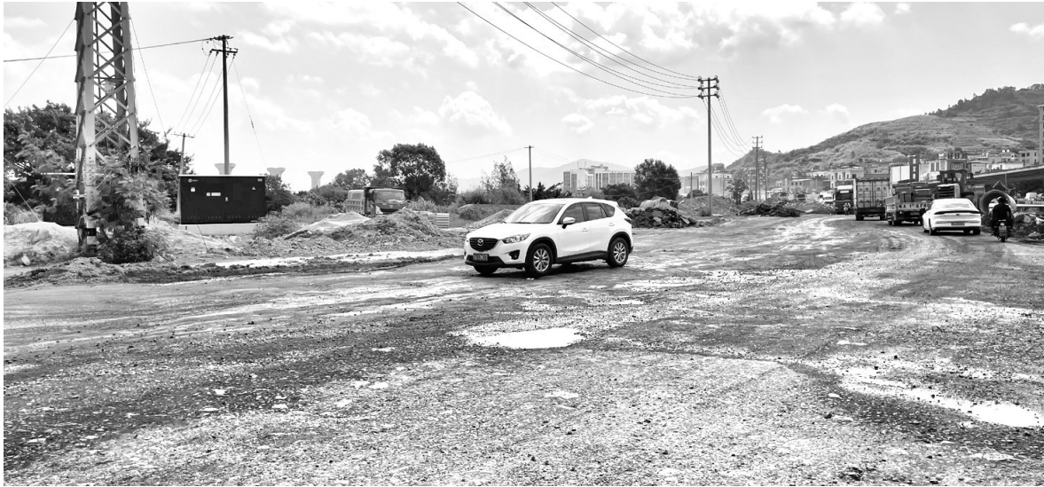
仍有部分路段坑坑洼洼,有积水
