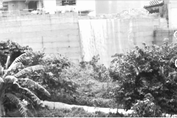
11日大雨中,混浊的泥水由工地护坡倾泻入小区
