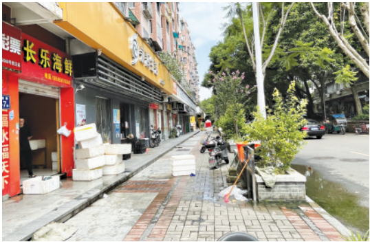
污水直流，路面已长青苔了
