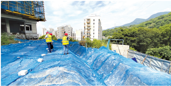
工地边缘加深了排水沟，并铺设了防水膜和覆盖网
