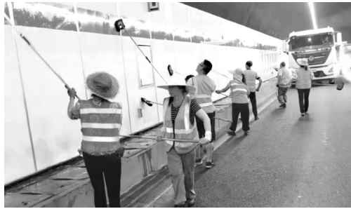
养护工人清洗隧道
