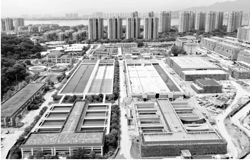
飞凤山水厂进行了扩建,深度处理工程将于年底完工
