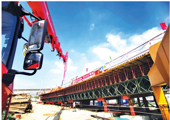
海山大道立交首联现浇箱梁浇筑
