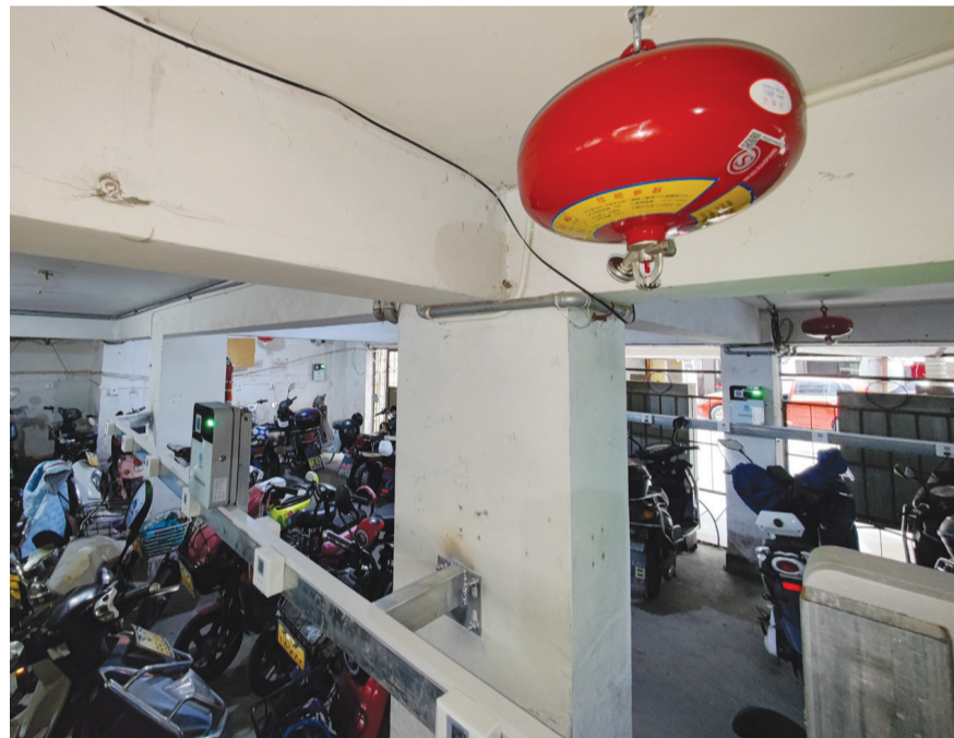
杨桥花园小区电动车停放区增设充电桩后,还加装了悬挂式遇热自爆灭火器
