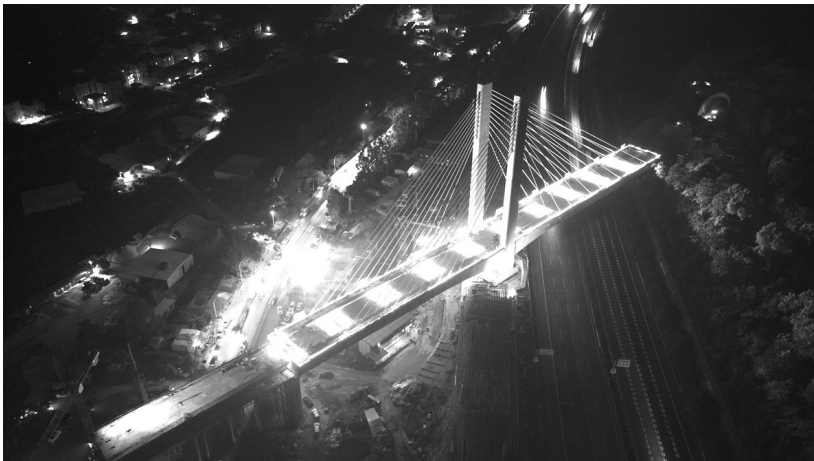
福厦高铁太城溪特大桥主跨合龙 丁明明/摄
