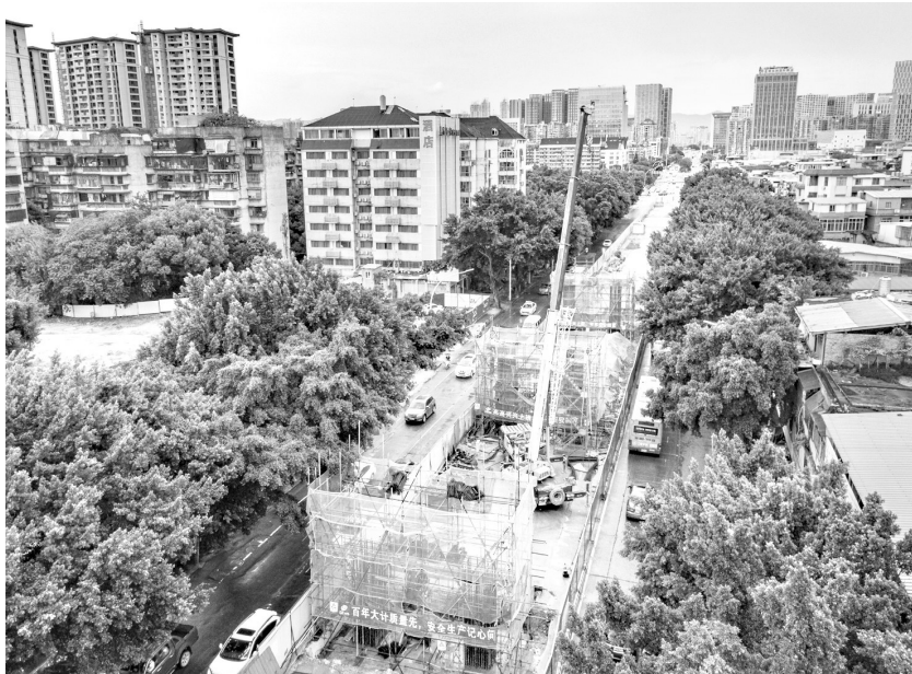
连江南路高架桥项目工地
