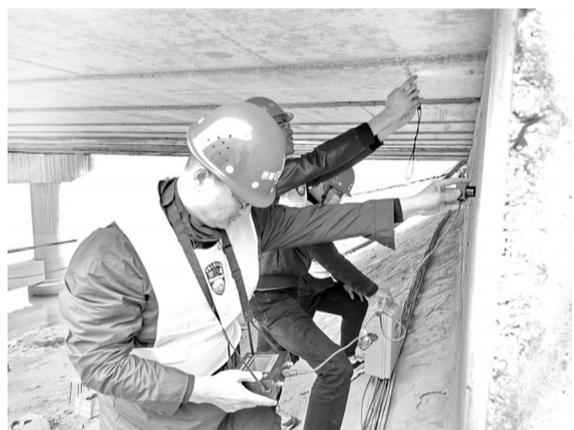
工作人员在桥底进行梁底裂缝检测
