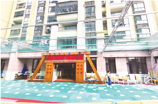
十六号楼一层被建设为幼儿园
