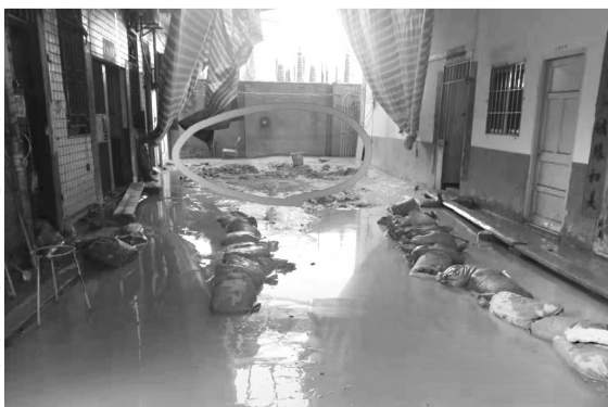
房东修管道,排出大量泥沙污水
