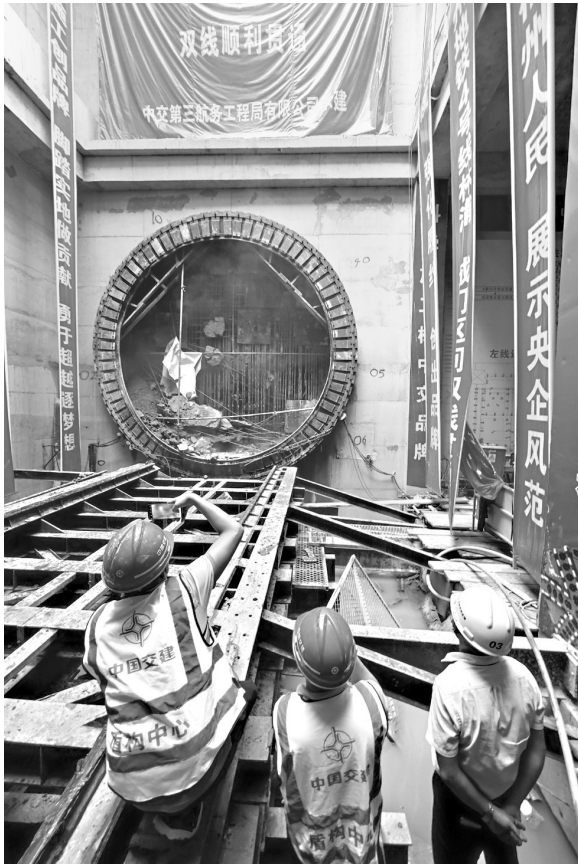
7日下午4时许,福州地铁4号线城门站右线盾构接收并破墙而出
