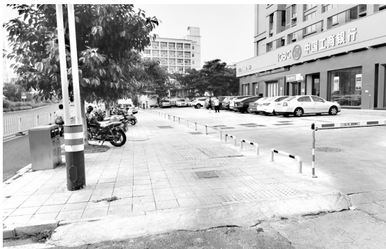
坤方九龙居停车场整改后,拆除了阻车设施
