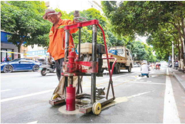
施工人员在泊位内钻孔以便安装地磁
