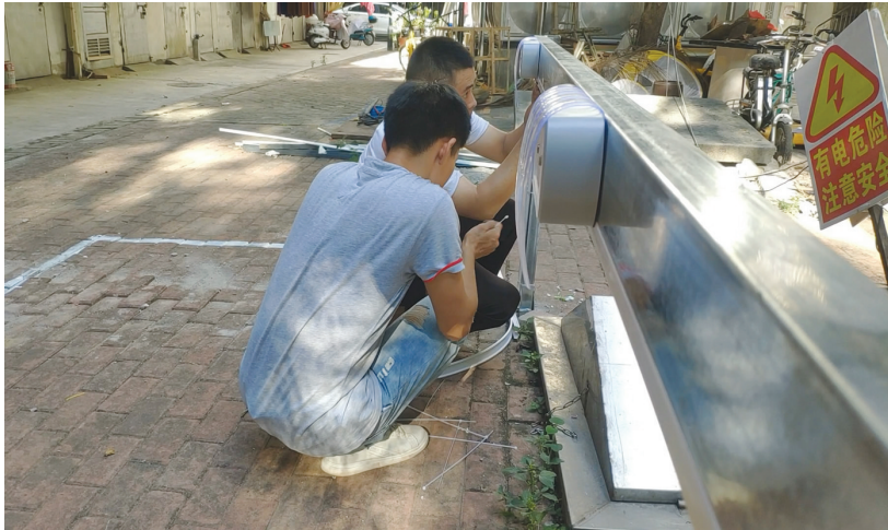
九日下午,工人正在布线安装插座
