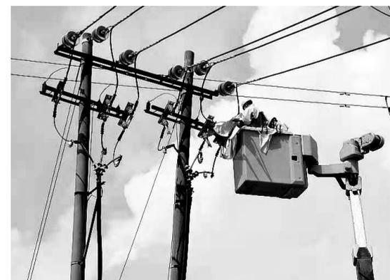
9月16日下午5时许,在秀屿区新厝店,国网莆田供电公司配网带电班连续完成10千伏笏西线两处刀闸发热缺陷,保障辖区内两个定点隔离酒店可靠用电。
