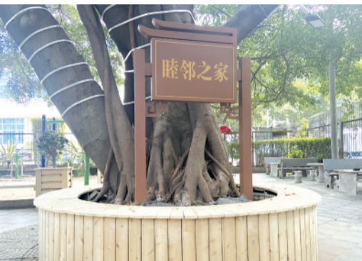
益力城小区的水泥树池,换成了木质的。
