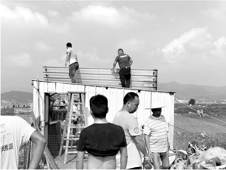
执法人员正在拆除凤窝村违建的集装箱
