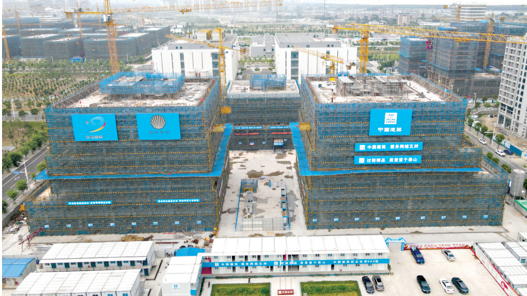
中国东南大数据产业园研发楼六期项目(陈琳摄)
