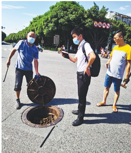
北渠管理处工作人员,在少林路查看雨污排放管道
