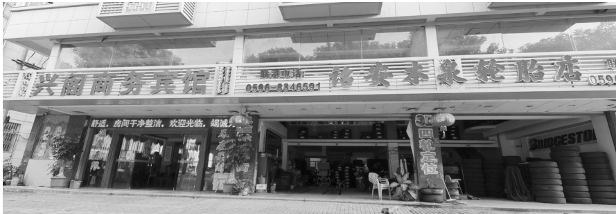
大楼一层除了宾馆大厅，还有一家轮胎店，存放着轮胎等易燃物
