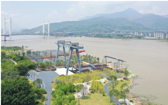
(船厂旧址)保留了龙门吊、轨道、钢结构等工业遗产文化
